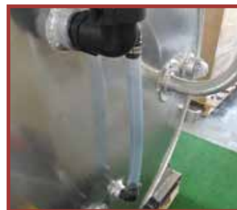
Rurka kontrolna do sprawdzania poziomu czystej wody
