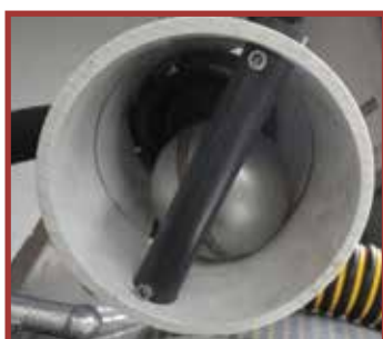
Główny odcinający zawór przelewowy z kulą ze stali nierdzewnej
